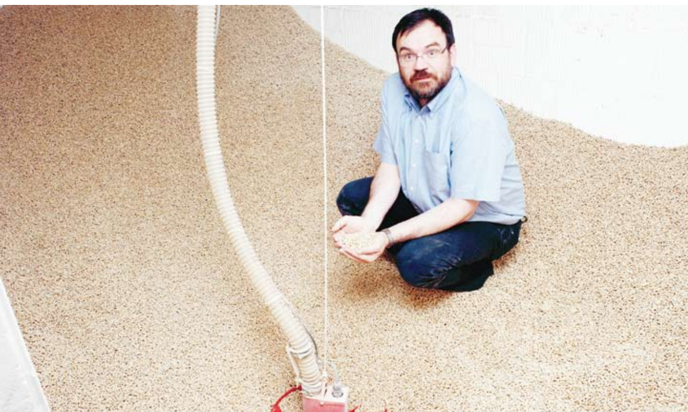
Im Pelletlager der Gemeinde: Heinrich Mühlenmeier, landeskirchlicher Umweltbeauftragter: „Pellets sind eine gute Wahl, um mit dem nachwachsenden Rohstoff Holz günstig und klimafreundlich zu heizen“
